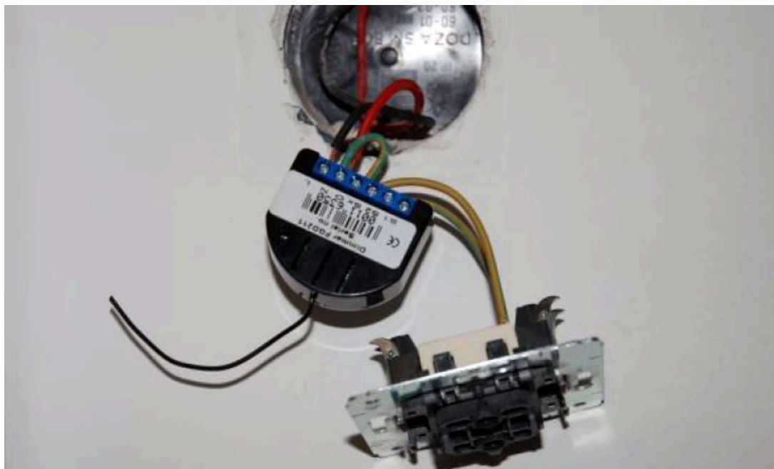
Рис. 7. Подключенный универсальный диммер компании Fibaro
